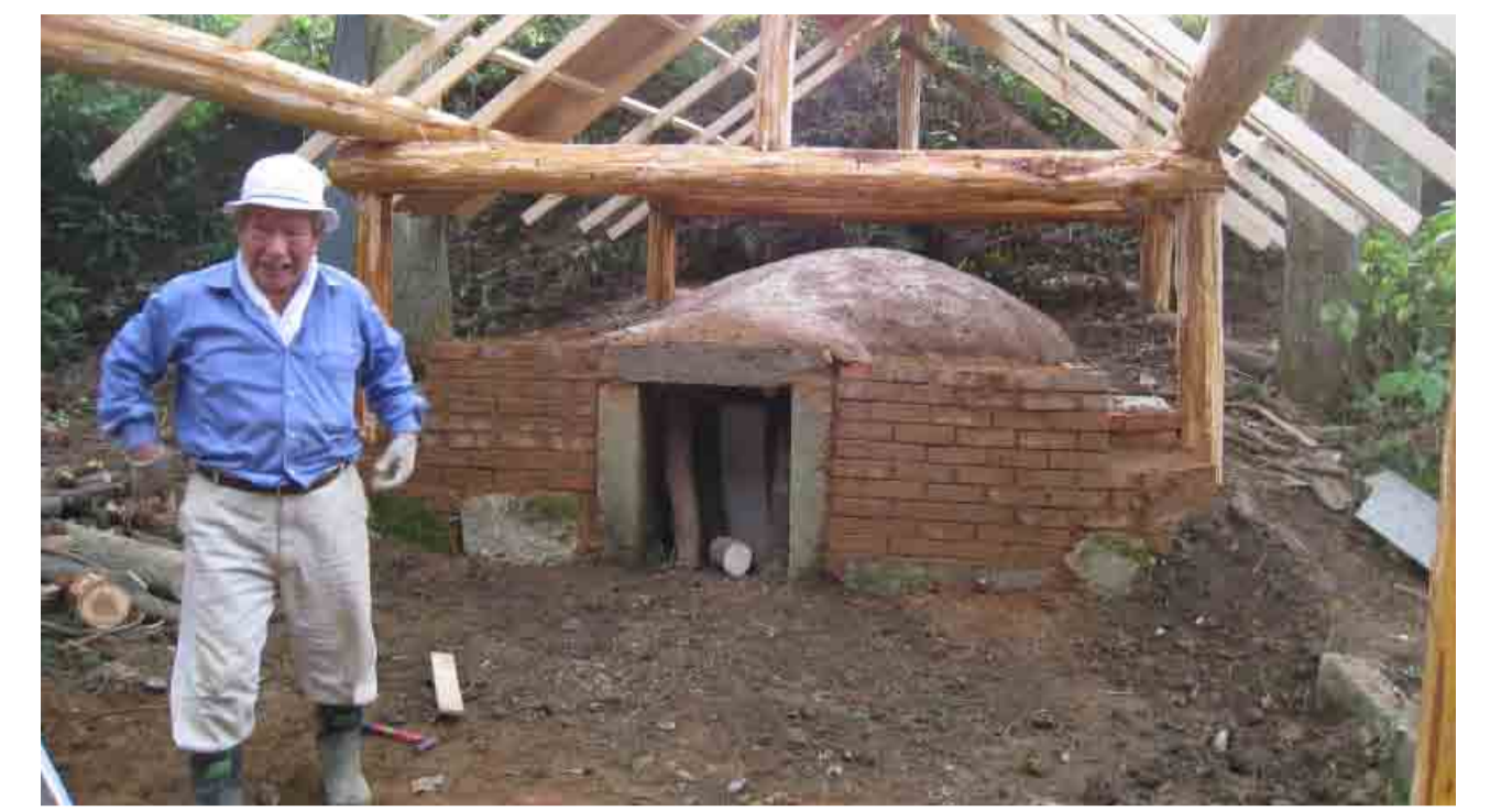
間伐材で窯の建屋
