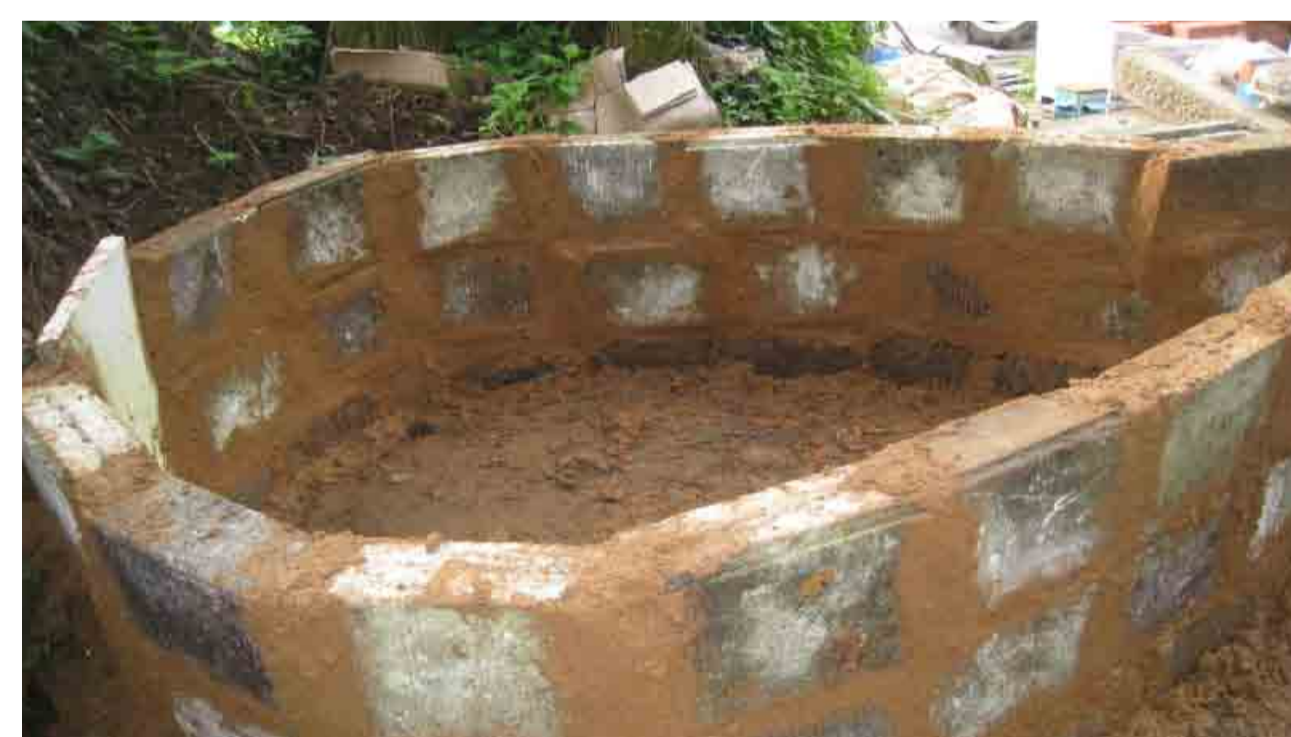
炭焼き窯基礎完成
