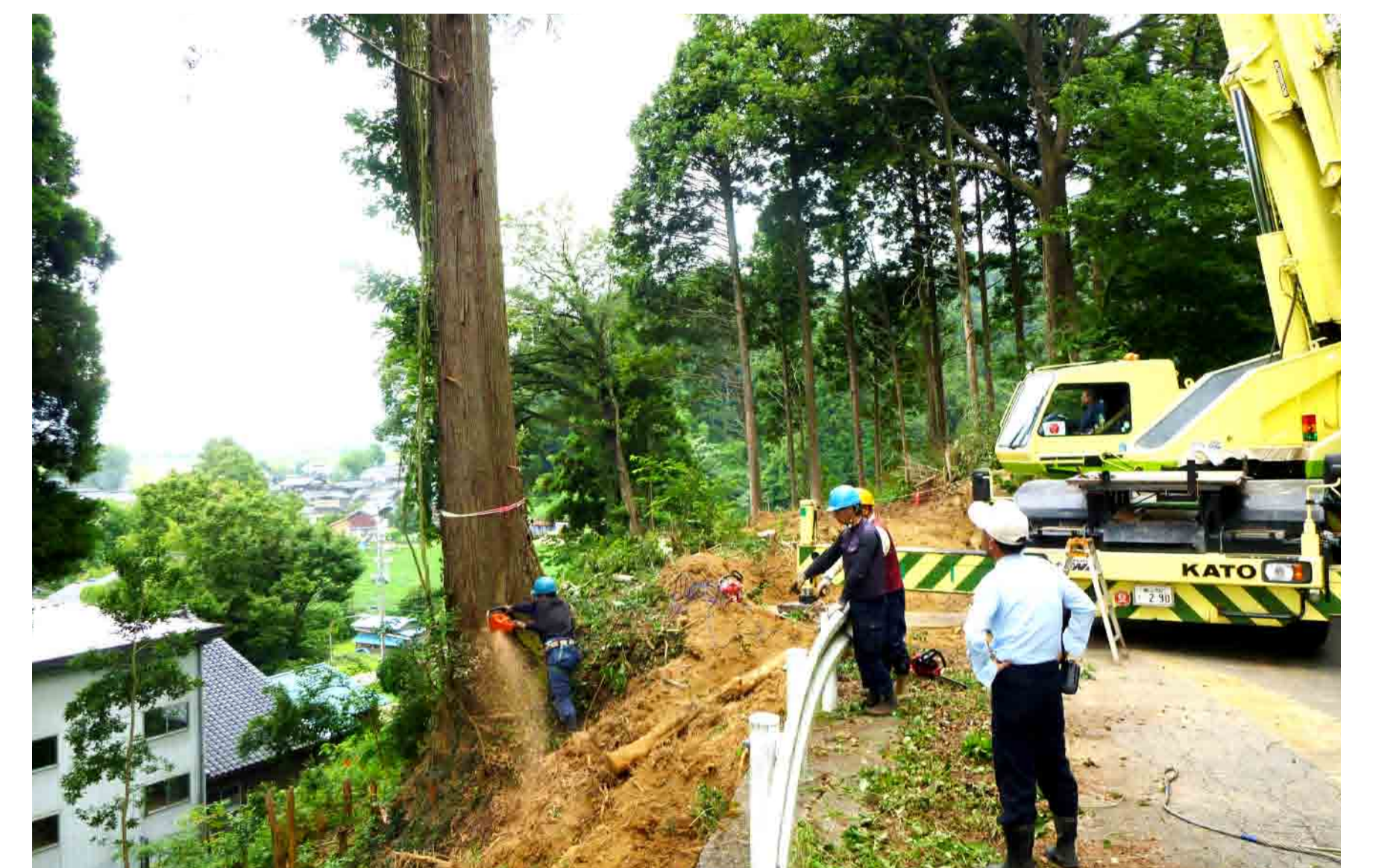
クレーンを使った吊るし切り作業-3
