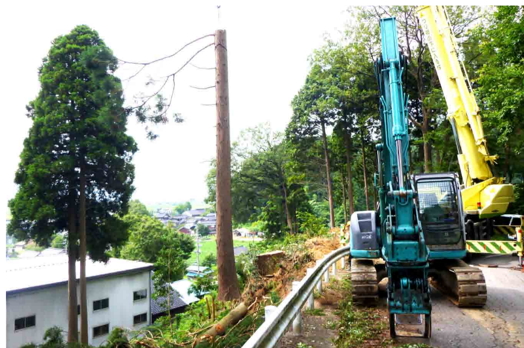
クレーンを使った吊るし切り作業-2
