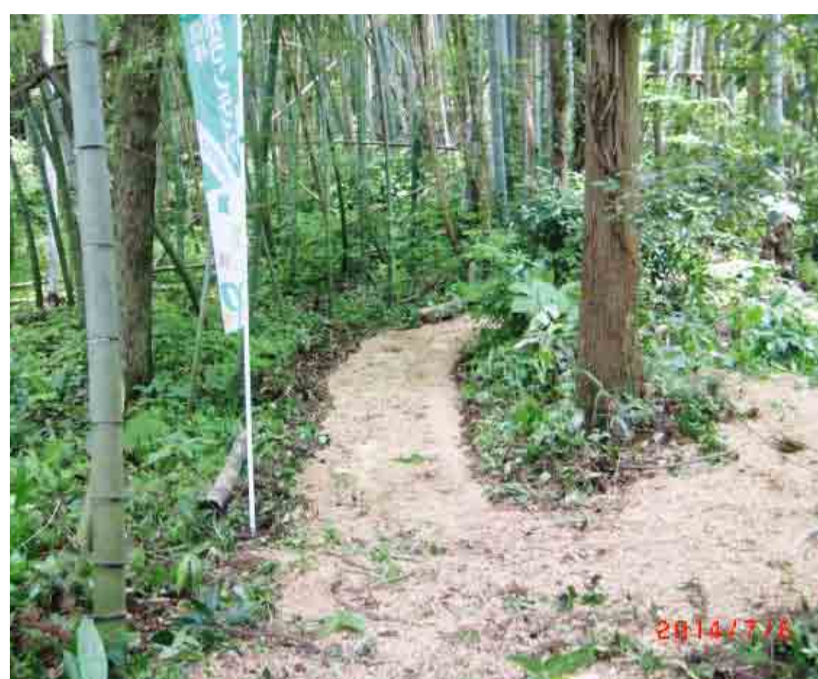
チップ敷設（雑草抑制）で管理歩道の改良
