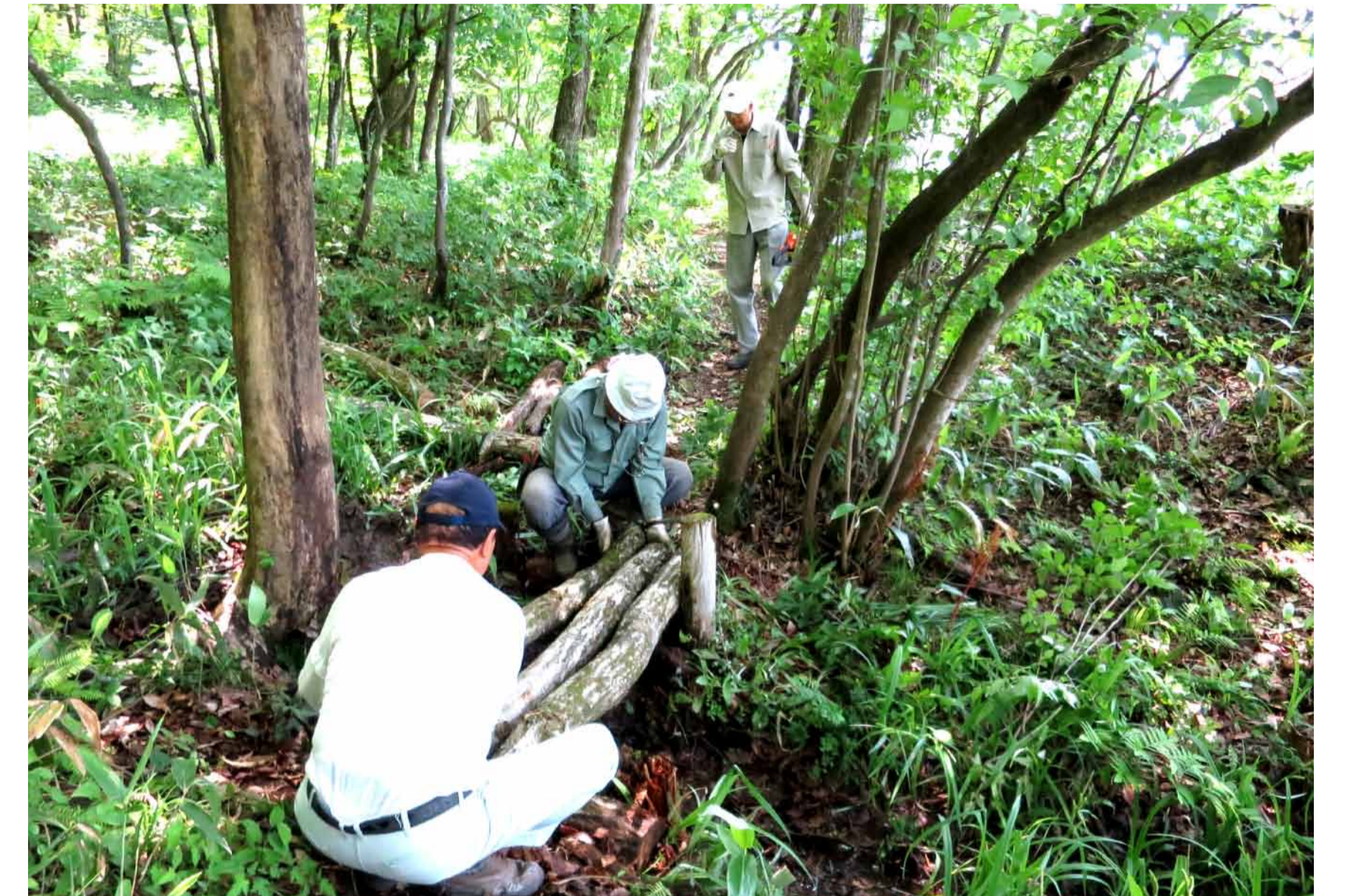
散策路の木橋整備
