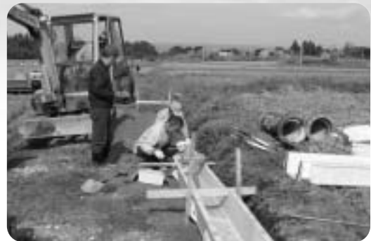
水路の自主施工
