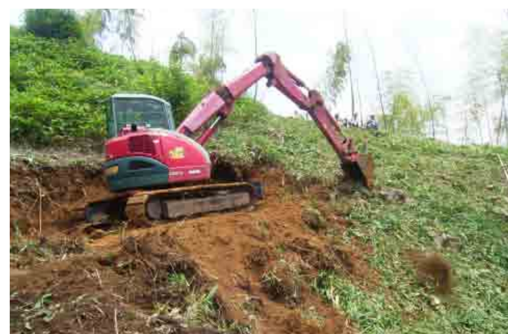
作業歩道開設
