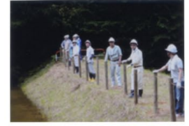
ため池周りに安全柵の設置
