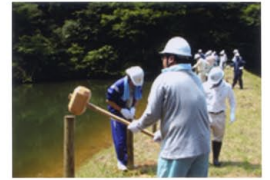
ため池周りに安全柵の設置
