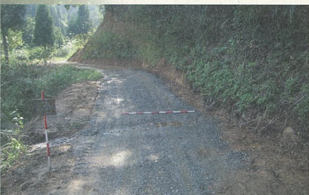
作業路補修 立山町栃津
